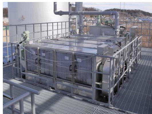
図8 ダウンサイジング型ベルトプレス Fig.8 Downsizing type belt press
