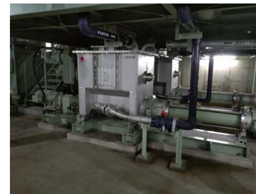
図4 混合ケーキ移送ポンプ Fig.4 Solid/liquid mixed sludge pump
