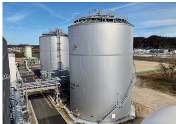
図6 鋼板製消化タンク Fig.6 Steel digestion tank
