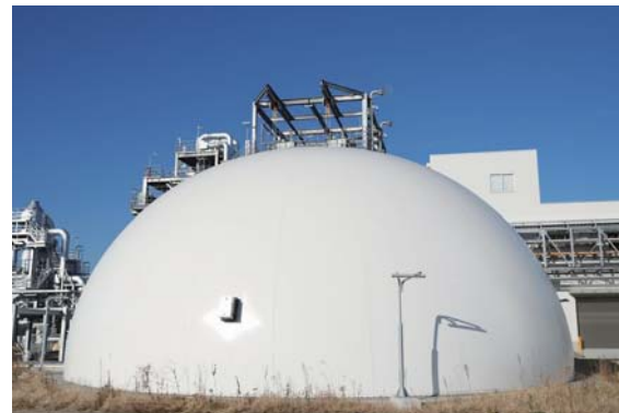
図7 メンブレン式ガスホルダ Fig.7 Membrane type gas holder
