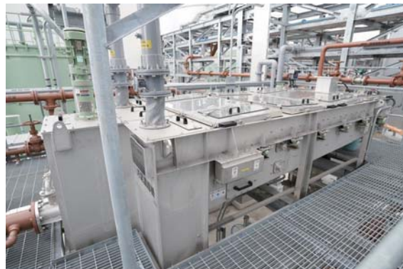
図5 ベルト式汚泥濃縮機 Fig.5 Belt type sludge thickener
