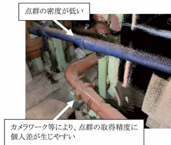
図2 LiDARスキャナで取得した点群データ Fig.2 Point cloud data acquired by LiDAR scanner
