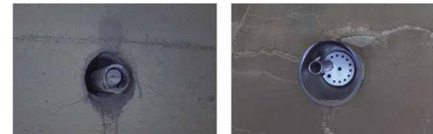
図2 炉内撮影画像(左：ウォーターガン/右：ガスガン) Fig.2 Inside the incinerator (Left : water gun / Right : gas gun)
