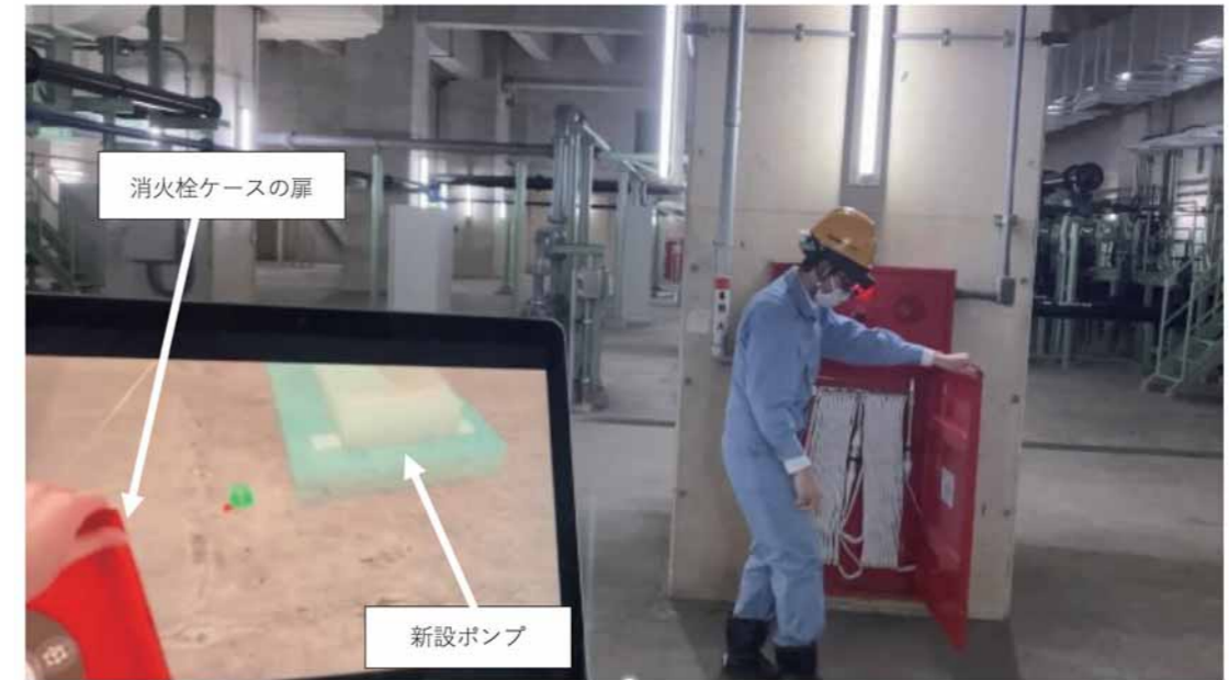
図1 発注図ベースでの既設消火栓と新設ポンプの配置干渉確認 Fig.1 Interference check on construction area using AR
