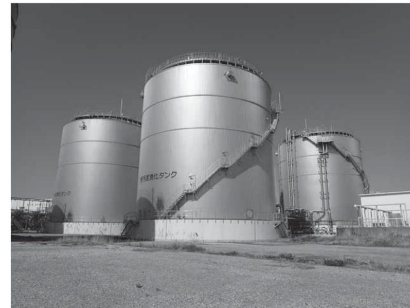
図1 汚泥消化タンク(下部コーン型鋼板製消化タンク)の写真
