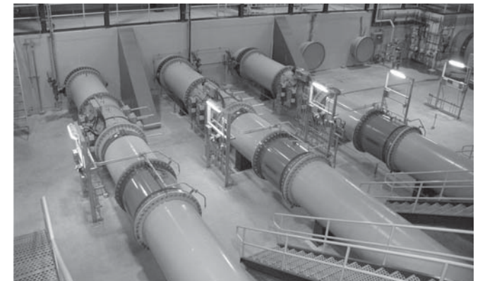
図2 北米実績 センチネル1200型(処理流量 = 360,000m 3 /日) Fig.2 Installation of SENTINEL Type 1200 in Canada (flow rate = 360,000m 3 /d)
