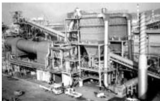
図1 コークス炉石炭用乾燥調湿設備
