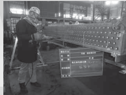
写真2 エアフィンクーラー リチュービング photo2 Air fin cooler retubing
