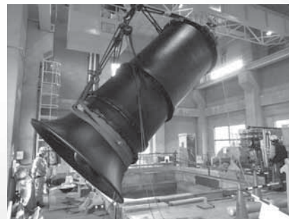
写真5 排水機場ポンプ据付 photo5 Drainage pump station construction
