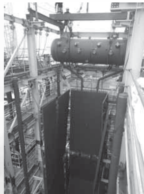
写真4 ボイラー組立 photo4 Boiler installation
