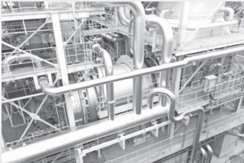
写真1 キルンストーカ炉写真 photo1 Kiln gasification system
