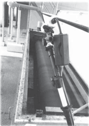
図8 ベルト濃縮機のケーキ排出部に設置した監視カメラと固定アーム Fig.8 Monitoring camera and arm for fixation set up in sludge discharge part of belt thickener
