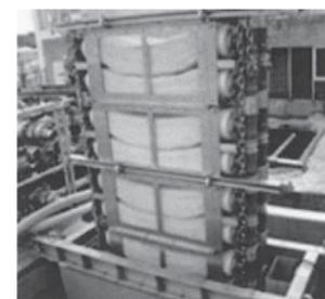
図9 膜モジュール引上げ状態
