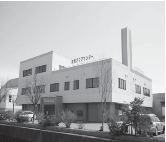
図5 紋別アクアセンター Fig.5 Mombetsu Aquu center
