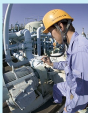
設備 メンテナンス
