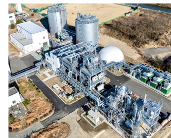
いわき市下水污泥等 利活用事業 (PFI事業)
