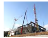
ごみ焼却炉プラント工事
